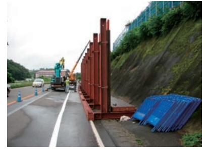
● 山留材組み立て基礎
