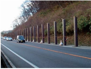
● H形鋼支柱打ち込み基礎
