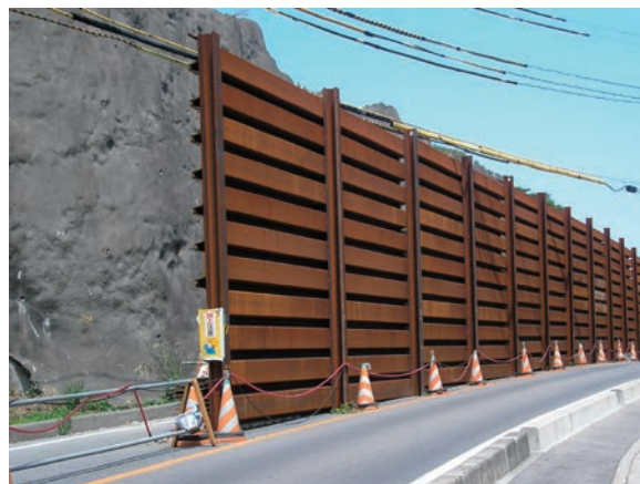
H形鋼支柱に鋼矢板を溶接で取り付ける
