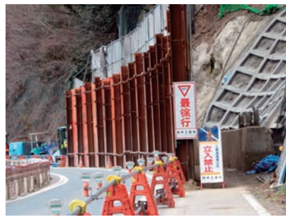
法面工事施工中の設置状況
