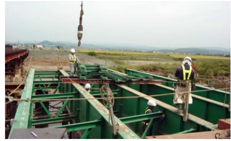
↓ 対傾構横構取付け
