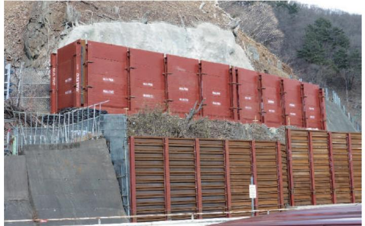
従来工法のH鋼支柱に取り付けた壁材(鋼矢板)が、パネルに進化しました。
