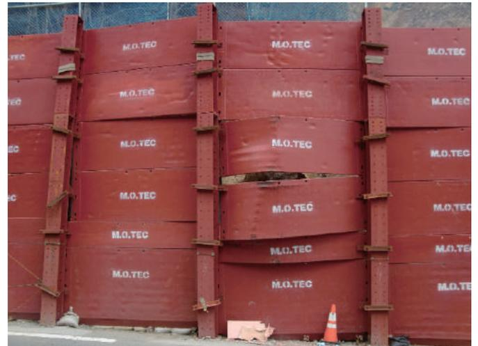
上記写真は想定外の落石が発生した現場で、落石の衝突により部材は大きく変形しましたが設置の目的である、通行車両・歩行者の安全は確保できました。
