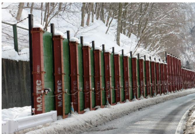
防雪柵を越える雪崩が発生した箇所に、応急対策として防護柵を設置しました。
