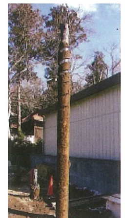
施工後に引き抜いた杭
