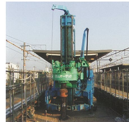
ホーム上施工
