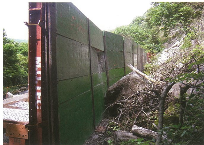
想定外の大きな落石にも連結効果で対応します
