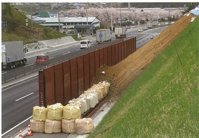
法面崩落の緊急災害発生時に設置した例
