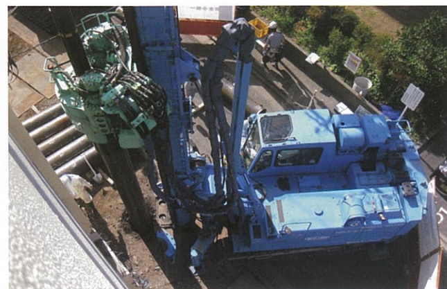
既存建物の近接施工
