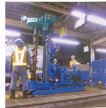
ホームドア施工
