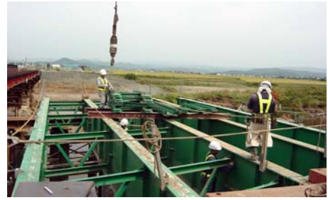
↓ 対傾構横構取付け
