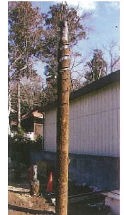
施工後に引き抜いた杭
