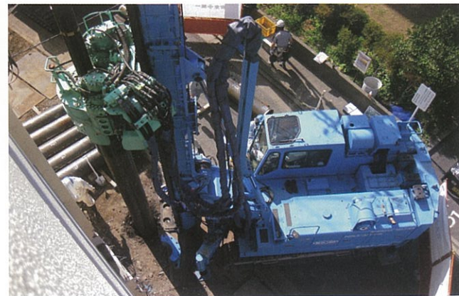
既存建物の近接施工
