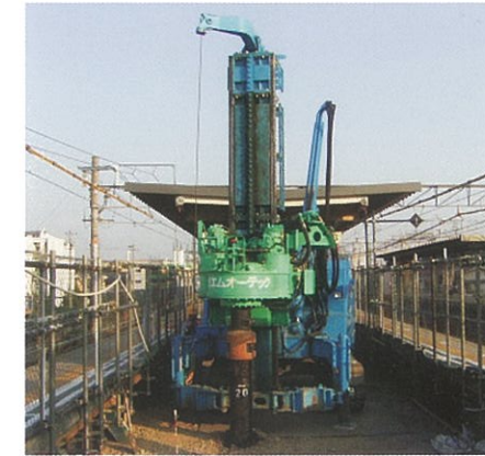
ホーム上施工
