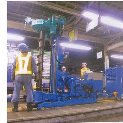
ホームドア施工
