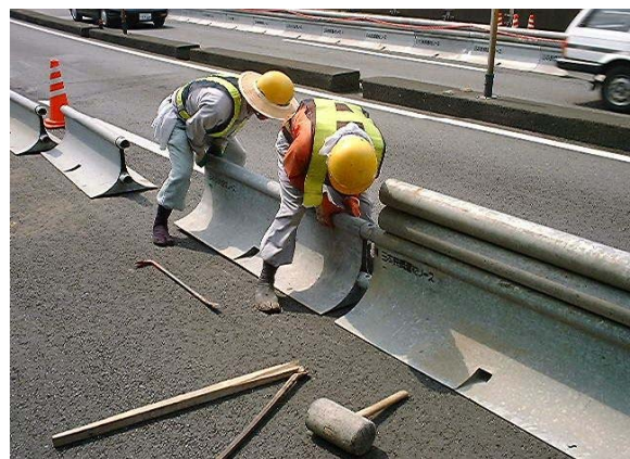
※組み立て作業状況
