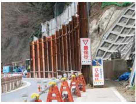
法面工事施工中の設置状況
