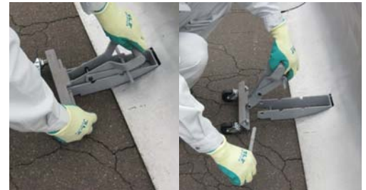
③ キャリー胴体部と脚部との接続解除と撤去状況
