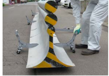
⑦ ミニガード持上げ完了・移動準備
