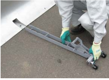
① ミニガードの中央孔にキャリーを配置
