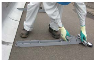
⑤ ミニガードからキャリーを引抜き撤去完了
